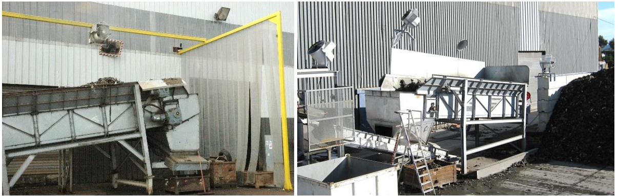
Figure 4: Derichebourg : traitement de déchets en extérieur
