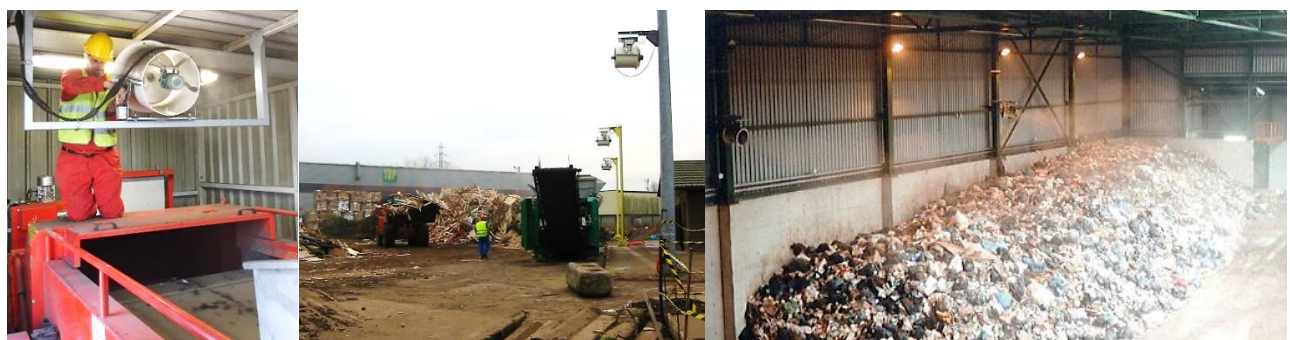
Traitement de grands volumes intérieurs et extérieurs
